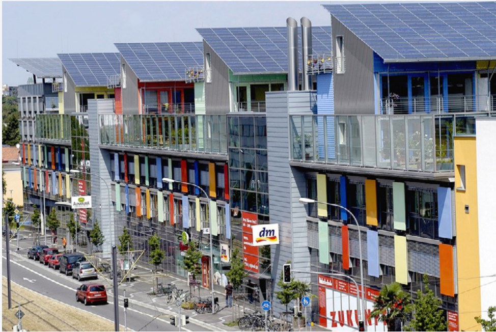
Figura 1. Sonnenschiff, Alemania. (Obtenida de: https://bz-ticket.de/sonnenschiff-und-solarsiedlung-freiburg )
