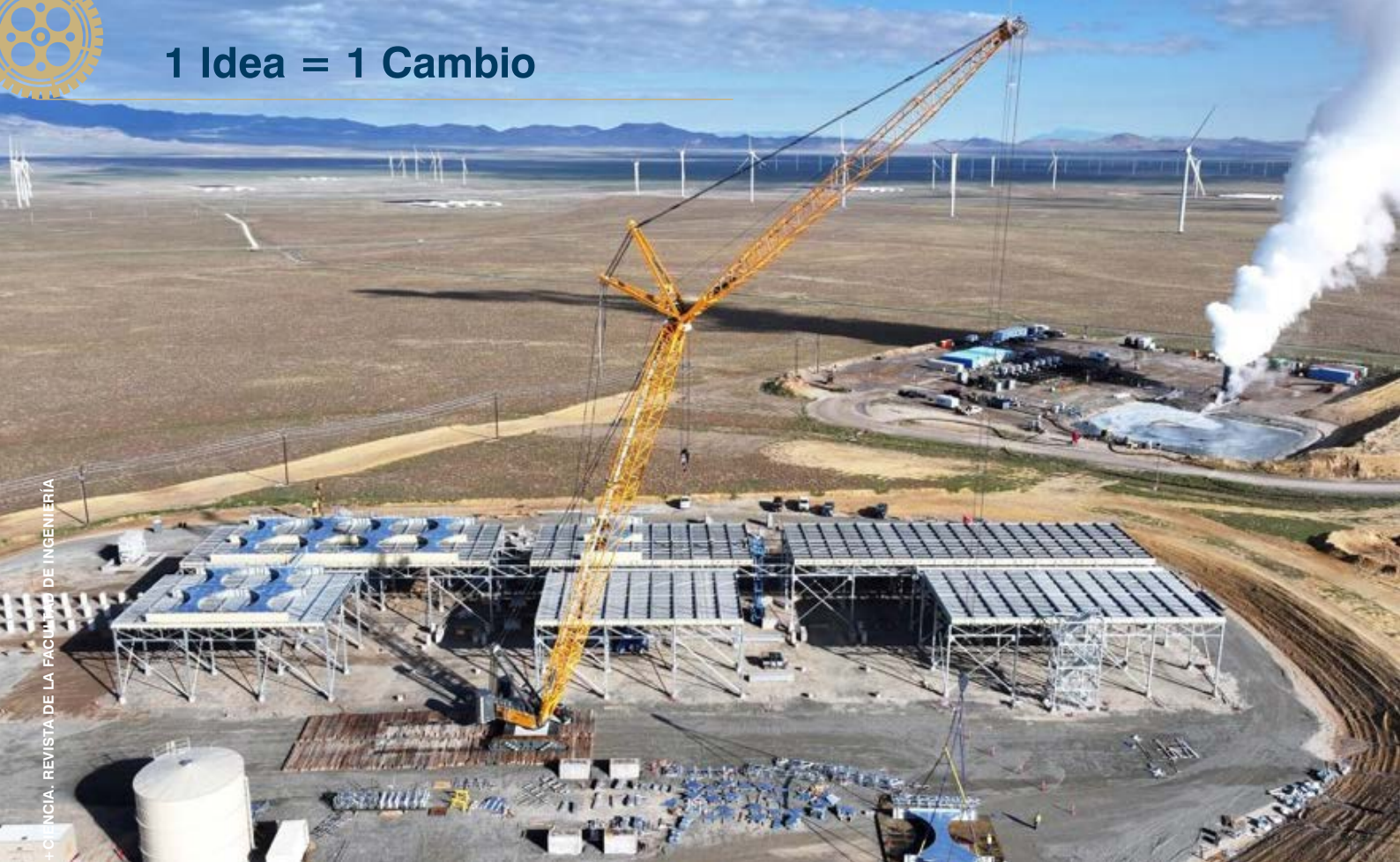
Figura 2. Construcción del proyecto Cape Station en Utah (Ardila, 2025b).
